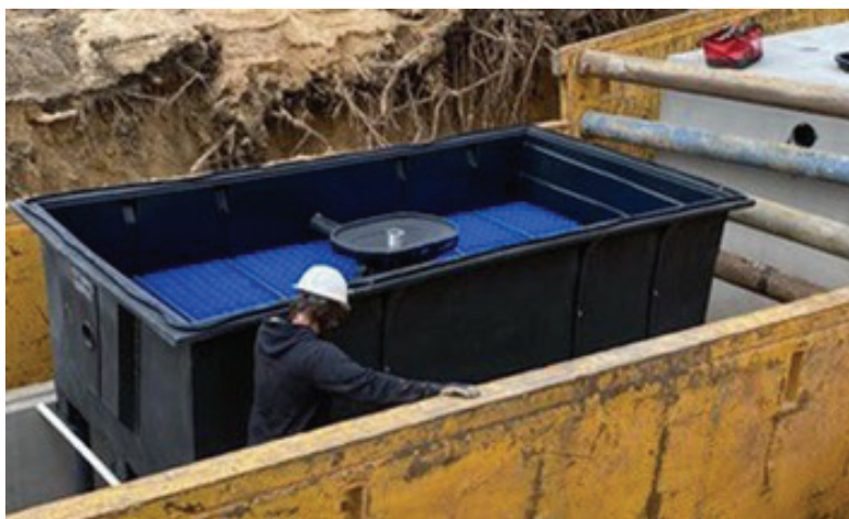
Gambar 6.5 Modul NitrifAST, buatan Biomicrobics dari Amerika Serikat
