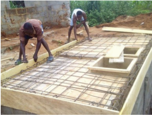
Gambar 2.1 Pembangunan Septic Tank Sumber: najjahouses.com
