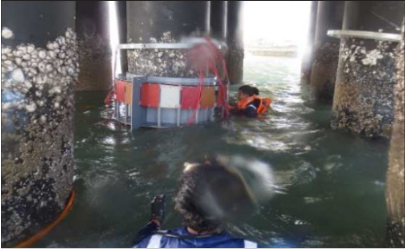
Gambar 3.6 Pemasangan sampel cat SPC-AF di pilar-pilar Jembatan Suramadu, Jawa Timur
