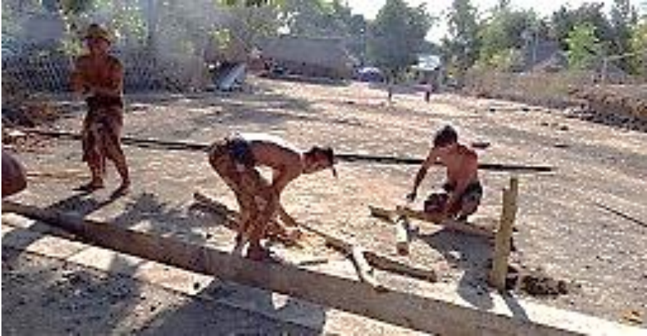
Gambar 28 | Pemasangan Tiang Balen Unggun (Foto: Suliadi)
