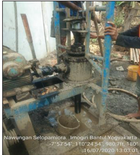
Gambar 4.5 Pengeboran air tanah dalam dengan menggunakan bor hidraulik untuk uji pompa air di Yogyakarta.
