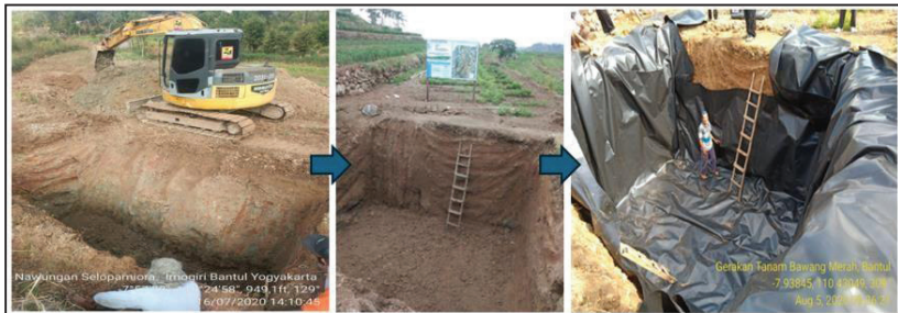
Gambar 4.6 Pembuatan embung mini berukuran 3 x 4 x 3 meter berlapis geomembran di Yogyakarta
