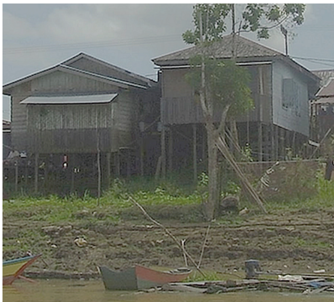
Gambar 3.17 Konstruksi rumah panggung yang menyesuaikan dengan muka air tertinggi periode penggenangan sebagai salah satu bentuk kearifan lokal masyarakat di kawasan Danau dataran banjir Mahakam. Rumah yang lebih baru (kanan) telah beradaptasi dengan tinggi genangan terakhir dalam catatan kolektif masyarakat setempat (Foto: Hidayat et al., 2017a)
