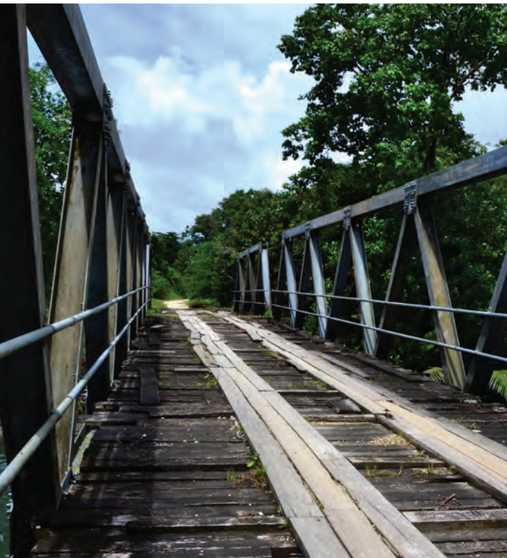
Jembatan di Pulau Enggano yang menggunakan kayu Merbau ( Intsia bijuga )
