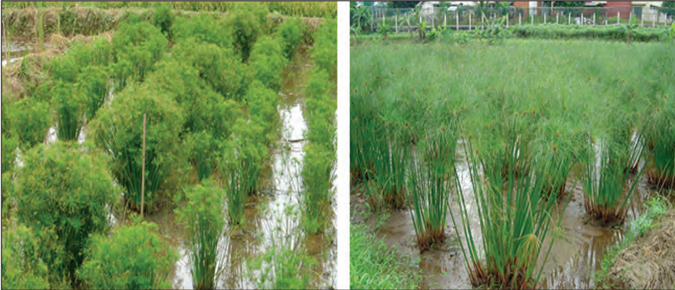
Gambar 5.19 Lahan Basah Buatan untuk Mengolah Air Limbah Pertanian Sebelum Masuk ke Situ Cibuntu
