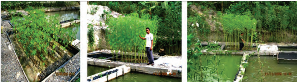
Gambar 5.20 Sistem Passive Treatment untuk Perbaikan Air Asam Kolong Bekas Tambang Timah untuk Sumber Air Kolam Ikan
