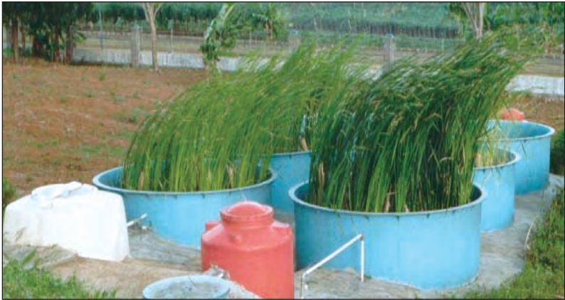
Gambar 5.18 Lahan Basah Buatan untuk Mengolah Air Limbah Laboratorium Puslit Limnologi
