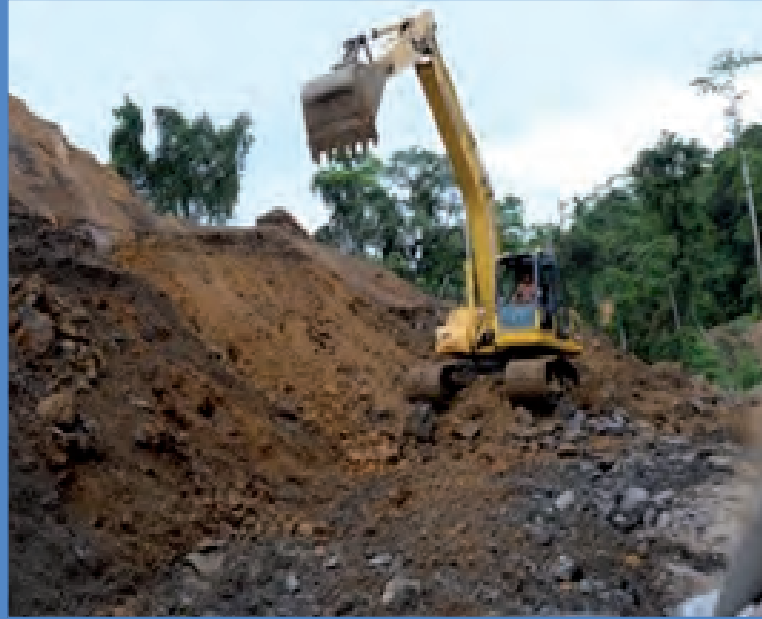
Pembangunan Infrastruktur Jalan Lintas Sorong-Manokwari yang Melewati Kawasan Pegunungan Tambrau
