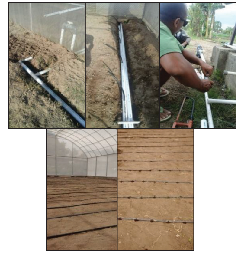
Gambar 27. Sistem irigasi tetes di sungkup ( net house ) di TP Banyumulek.
