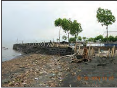
Gambar 10.4 Bambo yang Dibenamkan di Pantai untuk Mencegah Abrasi di Pantai Desa Gending
