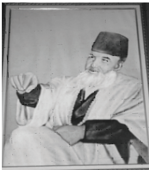
Gambar 4. Raja Baulolong Terakhir di Bungabali dari Alor Besar
