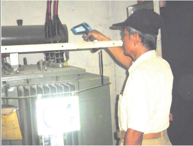
**Gambar 1.8** Penggunaan Termometer Inframerah pada Identifikasi Panas Trafo
