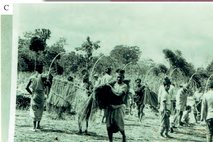
(A) Peninjauan Pembuatan Jalan di dalam Kebun Raya (B) Kondisi Jalan Kebun Raya (C) Gotong royong Masyarakat Sekitar Membangun Wantilan
