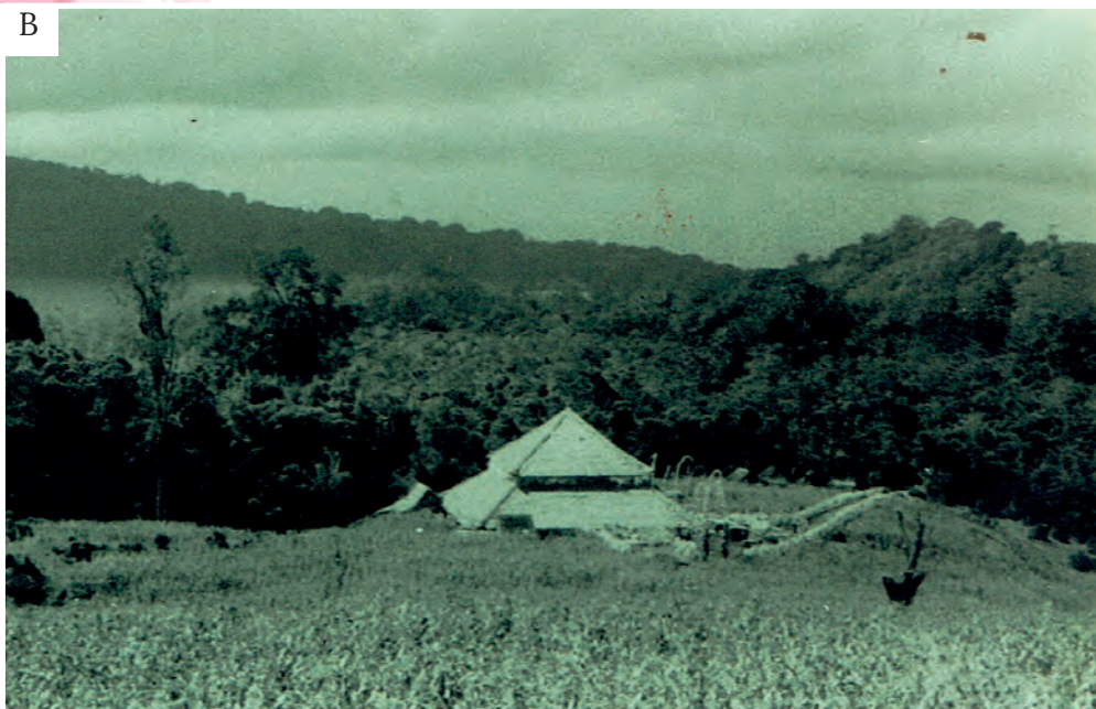
(A) Suasana Pembangunan Wantilan (B) Wantilan dilihat dari arah Taman Akuatik
