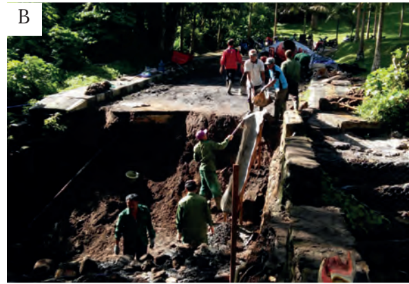
Jembatan dekat Koleksi Bambu: (A) Pascabencana, (B) Perbaikan, dan (C) Pascapembangunan kembali.
