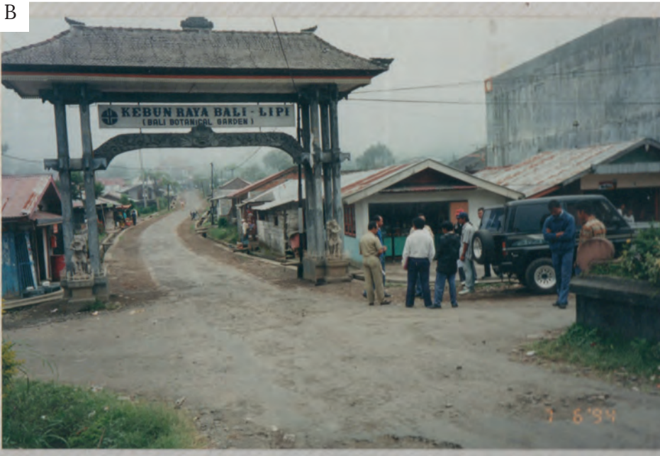
(A) Pembuatan Saluran Drainase (B) Gerbang Angkul-Angkul di Jalan Masuk Kebun Raya
