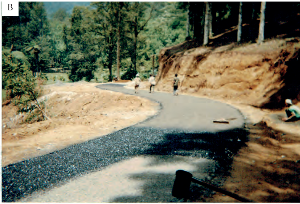
(A) Pembangunan Jalan Boulevard Ramayana (B) Pengaspalan Jalan Menuju Pura Teratai Bang
