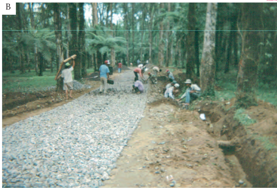
(A) Renovasi Rumah Kaca di Pembibitan (B) Pengaspalan Jalan
