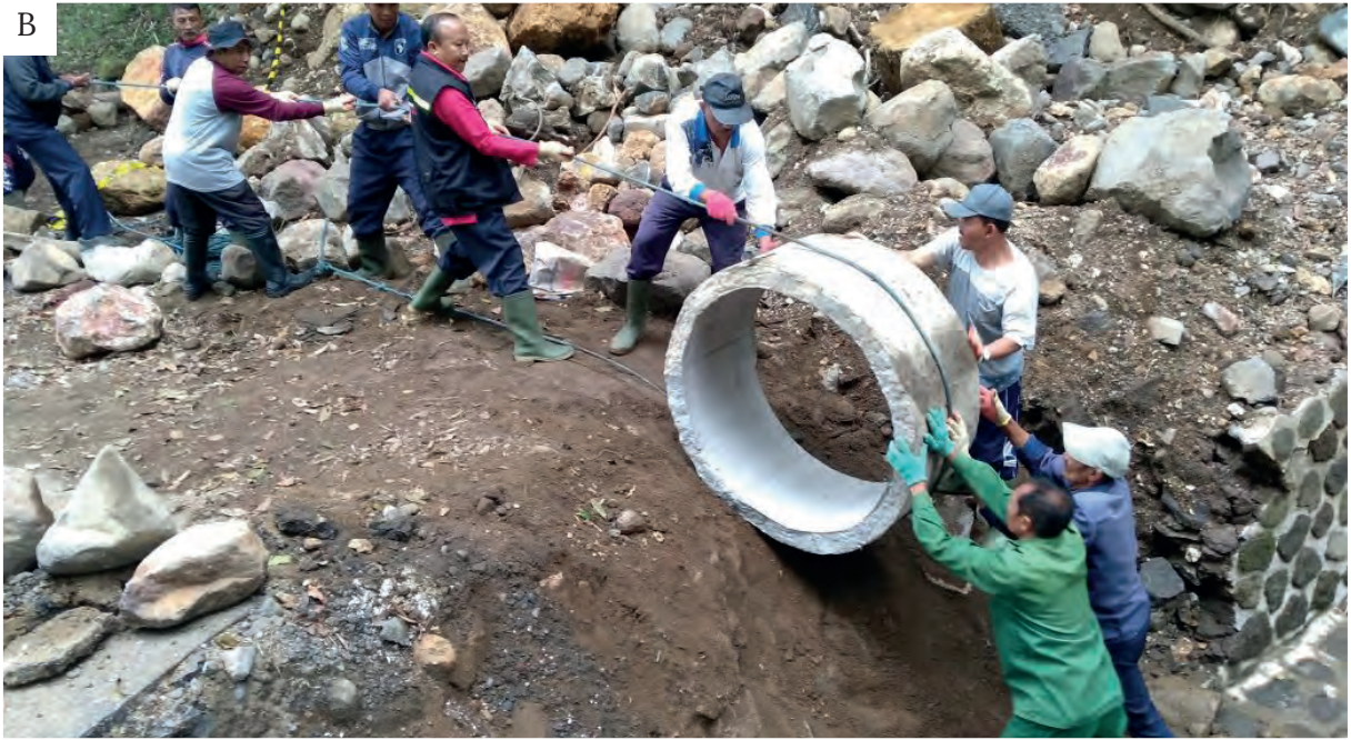
(A) Air deras mengalir dari arah Bukit Tapak (B) Gotong royong membangun kembali jembatan di belakang Koleksi Angrek.
