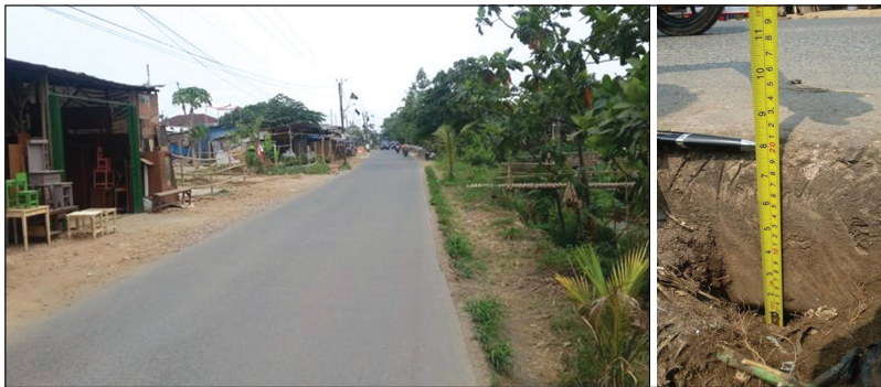
Gambar 3. Tampak Jalan Raya Cibinong, Tebal Perkerasan Kaku 20 cm (K300), Lebar 4,6 m di Kabupaten Bogor
