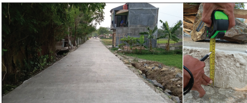
Gambar 7. Tampak Jalan Desa Babakan Madang, Tebal Perkerasan Kaku 15 cm (K250), Lebar 3 m di Kabupaten Bogor
