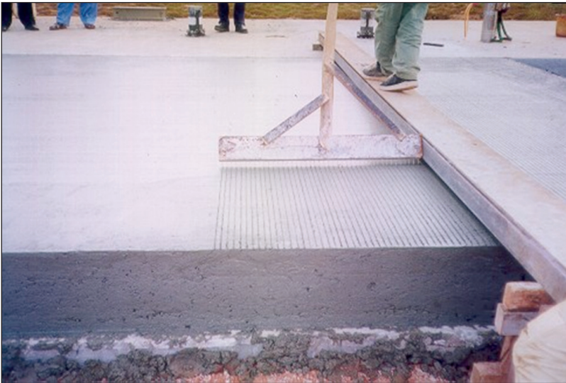
Gambar 47. Pembuatan Alur dengan Sisir Kawat sampai Kedalaman 3–6 mm
