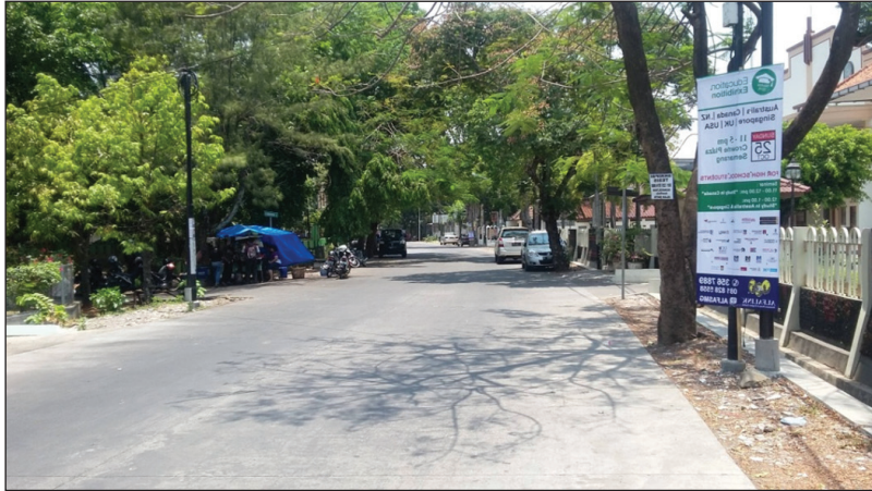
Gambar 16. Tampak Jalan Atmodirono, Tebal Perkerasan Kaku 20 cm (K300), lebar 9 m di Kota Semarang
