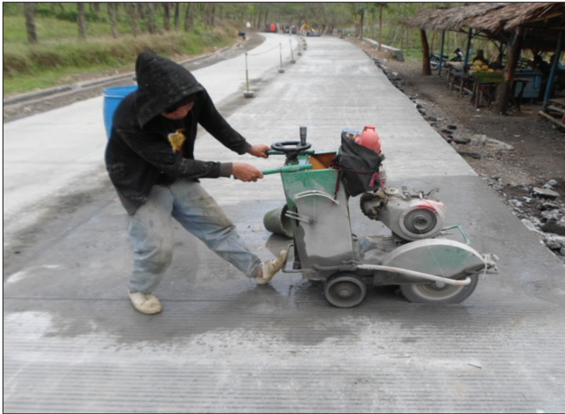
Gambar 50. Pembuatan Sambungan/Penggergajian
