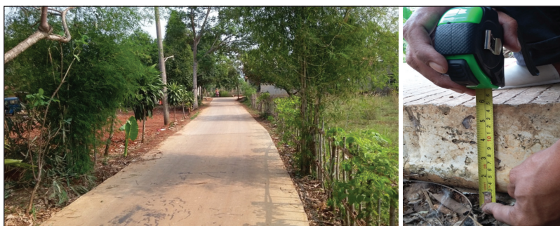
Gambar 6. Tampak Jalan Kali Putih, Tebal Perkerasan Kaku 15 cm (K250), Lebar 3 m di Kabupaten Bogor
