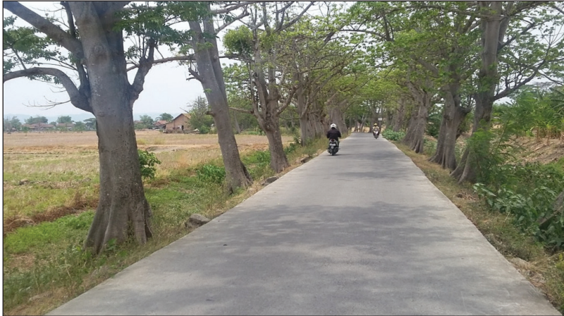
Gambar 13. Tampak Jalan Payaman–Karang Rowo, Tebal Perkerasan Kaku 20 cm (K300), Lebar 4,0 m di Kab. Kudus
