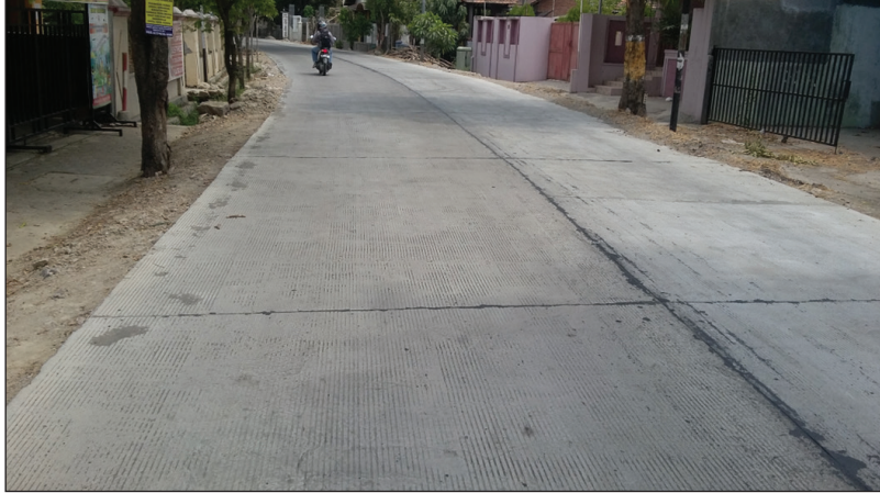
Gambar 15. Tampak Jalan Gondang Manis, Tebal Perkerasan Kaku 25 cm (K350), Lebar 4,5 m di Kab. Kudus
