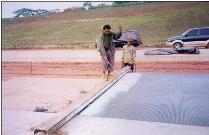
Gambar 48. Perawatan dengan Cara Penyemprotan Pigmen Putih
