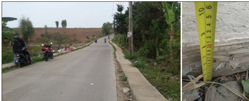
Gambar 5. Tampak Jalan Ragajaya, Tebal Perkerasan Kaku 20 cm (K300), Lebar 4,6 m di Kabupaten Bogor
