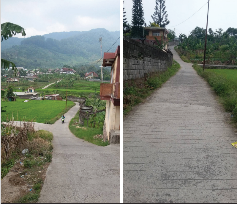
Gambar 8. Tampak Jalan Desa Batu Layang–Puncak Bogor, Tebal Perkerasan Kaku 15 cm (K250), Lebar 3 m di Kabupaten Bogor
