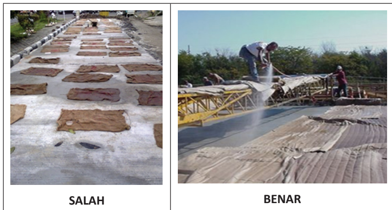
Gambar 64. Metode Perawatan Beton Menggunakan Goni/Burlap
