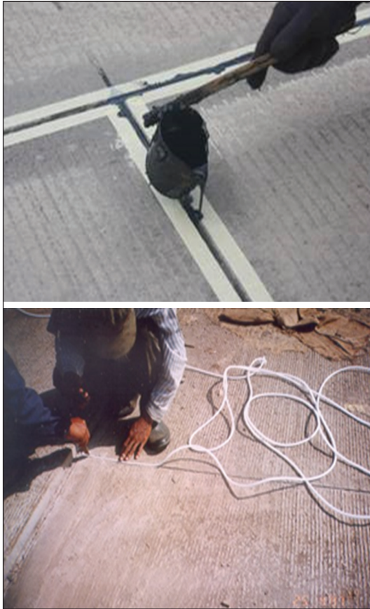
Gambar 51. Penutup Sambungan dengan Termoplastik Tuang Panas dan Sealant
