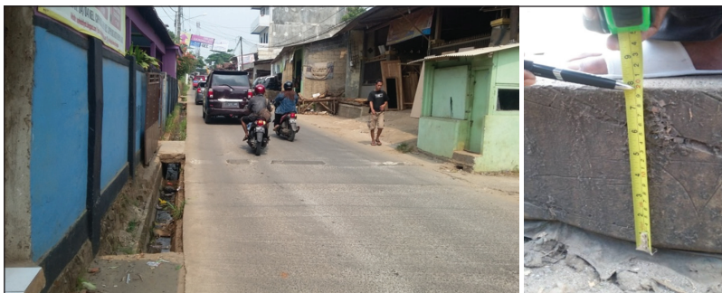
Gambar 4. Tampak Jalan Perdesaan, Tebal Perkerasan Kaku 20 cm (K300), Lebar 4,6 m di Kabupaten Bogor
