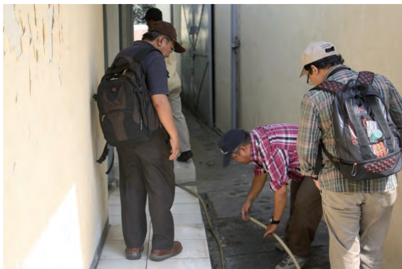
Gambar 1.4 Pipa Aliran Sumur Artesis di Jln. Tongkol, Jakarta Utara
