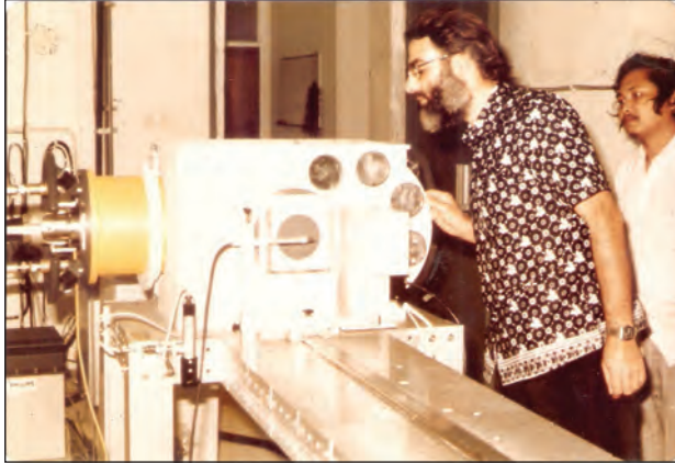
Gambar 2.8 Pemasangan Roda Filter pada Pesawat Sinar-X MG-420 Tahun 1982
