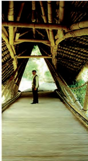
**Gambar 65.** Jembatan dengan kerangka bambu di Tukad Badung
