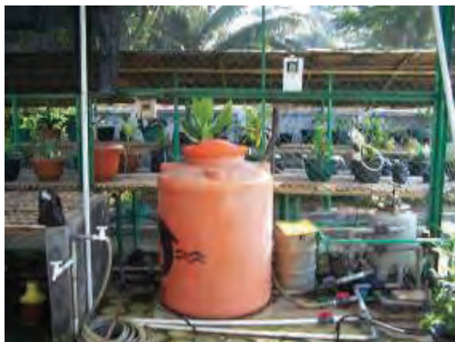
Gambar 15. Unit Peralatan Pompa Air, Penjernih Air, Bak Air Plastik Fiber, dan Timer Otomatis
