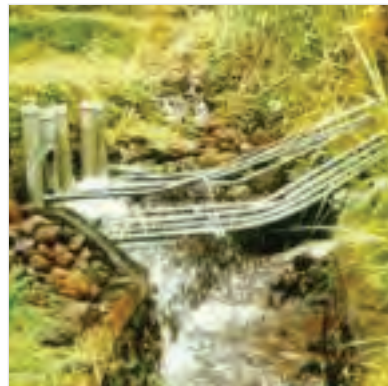
Gambar 56. Pompa Hidram Di- instalasi secara Paralel
