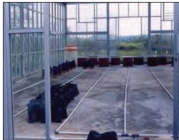
Gambar 61. Tampak Depan Greenhouse Tipe Kaca dan Rangka Aluminium dengan Irigasi Sistem Tetes Tipe Sekrup Gambar 62. Jaringan Pipa Irigasi Sistem Tetes Tipe Sekrup di Dalam Greenhouse Tipe Kaca Rangka Aluminium
