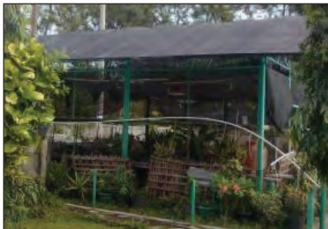
Gambar 67. Tampak Samping Greenhouse Tipe Agronet 70% dan Rangka Besi Siku atau Kawat Ayam dengan Irigasi Sistem Manual
