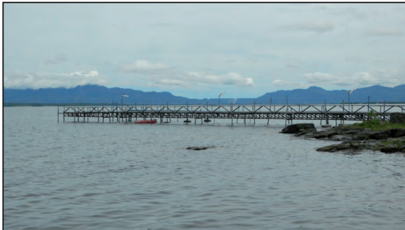
Gambar 25. Titik pengambilan (intake) air baku PDAM di Kota Balige. (Foto: Lukman)
