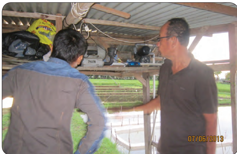
Gambar 1.9 Memeriksa peralatan pompa air dan blower untuk kolam kain.
